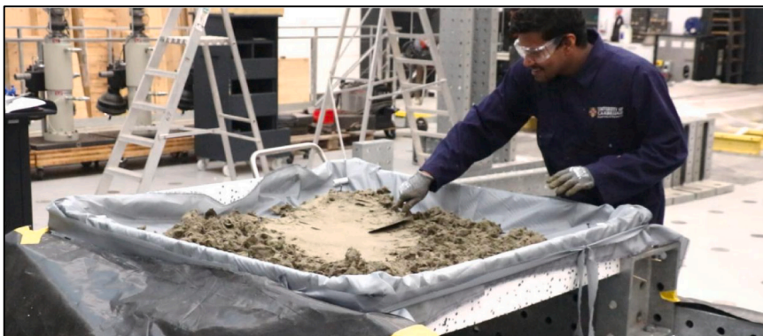
(d) Concreting the shell
